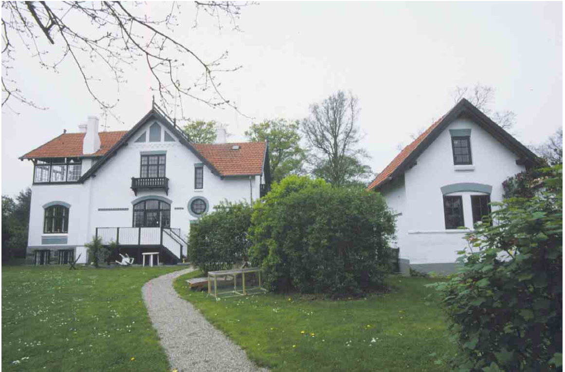
Rue Villavej 31 er et enestående velbevaret eksempel på dansk skønvirke.
