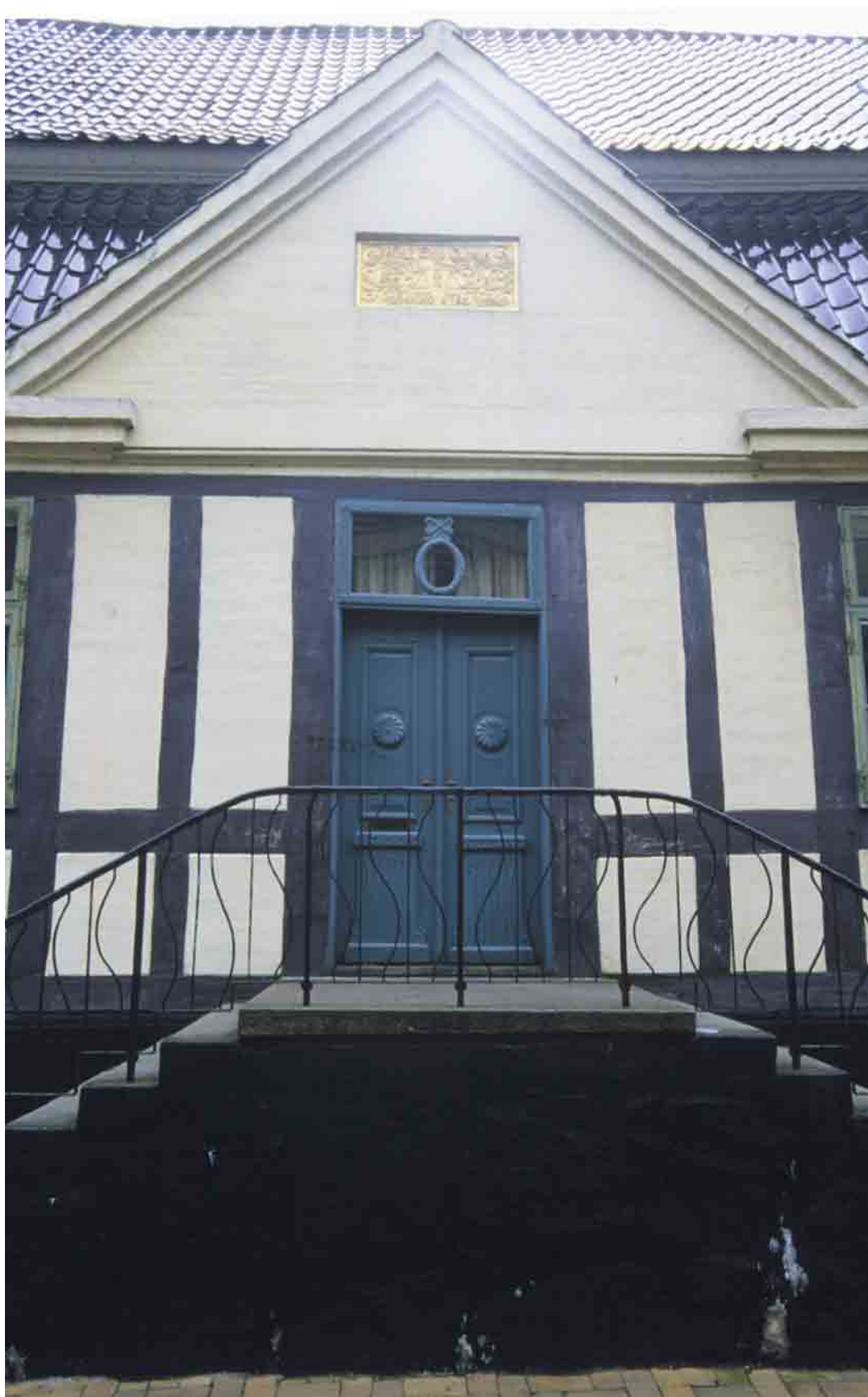
Østergade 24's indgangsparti er tydeligt markeret i facaden med trekantspids og dobbeltløbende trappe.
