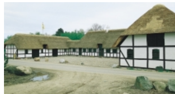
Hannebjergvej 4 i Hennemved repræsenterer den trelængede gård i gennemført bindingsværk. En stor velbygget gård med strå på taget og gårdsplads helt op til vejen.
