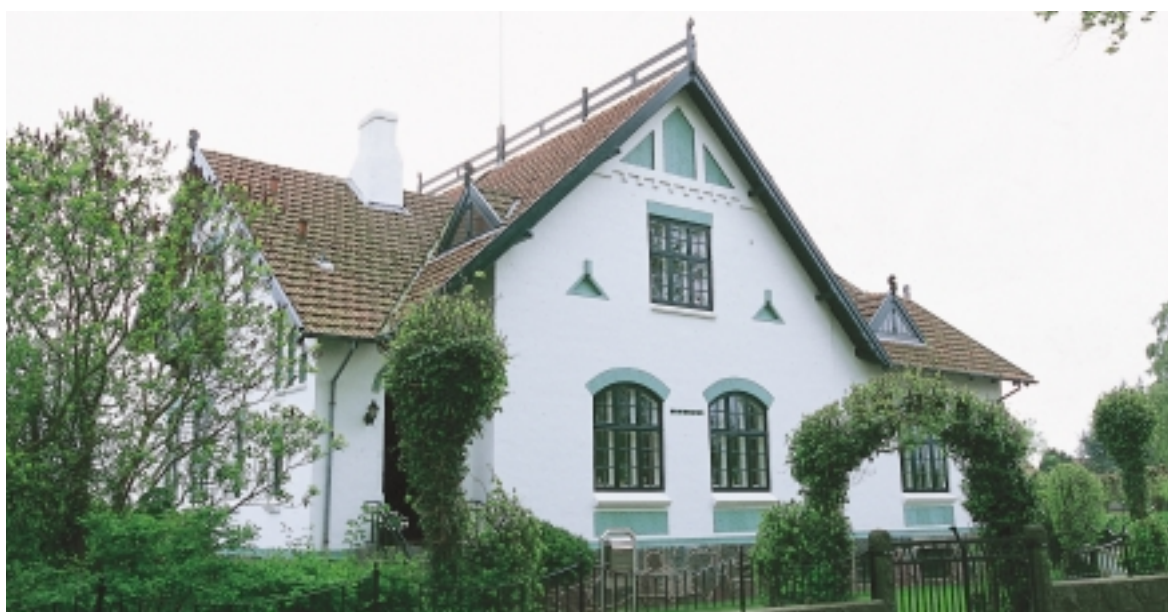
Rue 31 fra år 1900 er et gennemført eksempel på skønvirkestilens motivverden, med bl.a. reminiscenser fra den nordiske vikingetid. Jf. rygningens udvendige tagstol og de dragelinende brandstænger ved alle tagspidserne.
