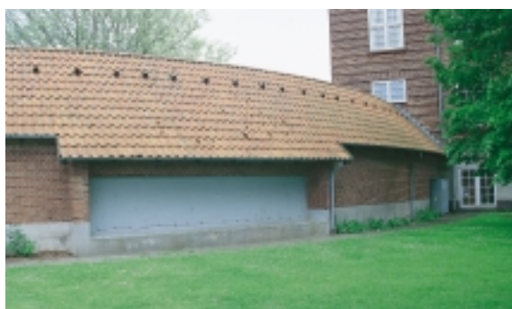
Den gamle og nye skolebygning er ganske raffineret sammenbygget ved hjælp af en stor buet mellembygning, som mod skolegården tjener til læskur.
