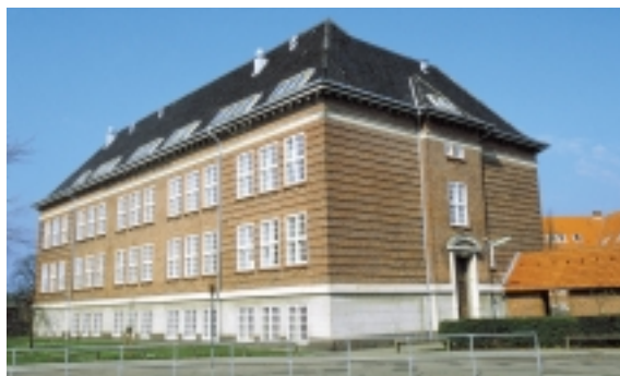
Den store tunge og formelle skolebygning på Kastanievej står som en fuldgyldig repræsentant for den tids skolearkitektur.
