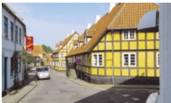
Nørregades bindingsværksbyggeri udgør et usædvanlig helstøbt bymiljø - domineret af de store købmandsgårde.
