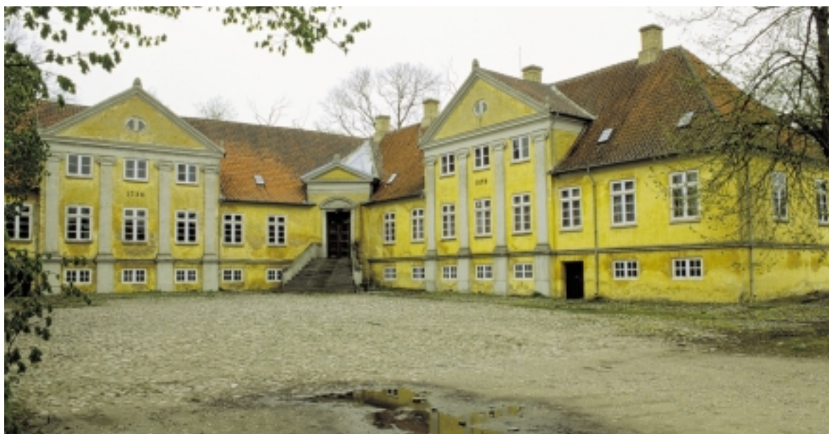
Broløkkes fint pudsede hovedhus fra 1758 fik godt 100 år senere sin kloning. En nøjagtig kopi af det oprindelige hus opførtes vinkelret på det gamle.
