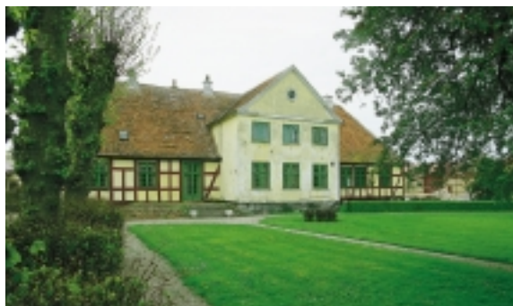
Søvertorps barokke hovedbygning har til havesiden fået tilføjet en markant, fuldmuret midtrisalit.
