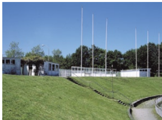
Gentofte Stadion er anlagt i en tidligere lergrav, hvor det omkalfatrede landskab har fået en ny anvendelse.
