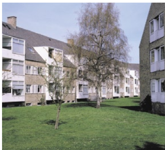
Ibstrupparken I består af tre boligblokke, hvis forskellige længder er bestemt af den trekantede grund. Blokkene har i hver ende et lille knæk, som relaterer sig til de omgivende veje. Udformningen med de iøjnefaldende altankarnappartier har et vist slægtskab med Alléhusene.
