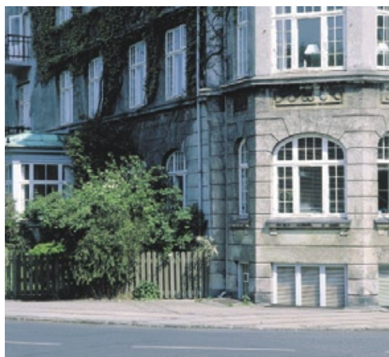
Husene på Strandvejen i Hellerup har en høj detaljeringsgrad som her med refendfuget underetage og opsprossede vinduer.
