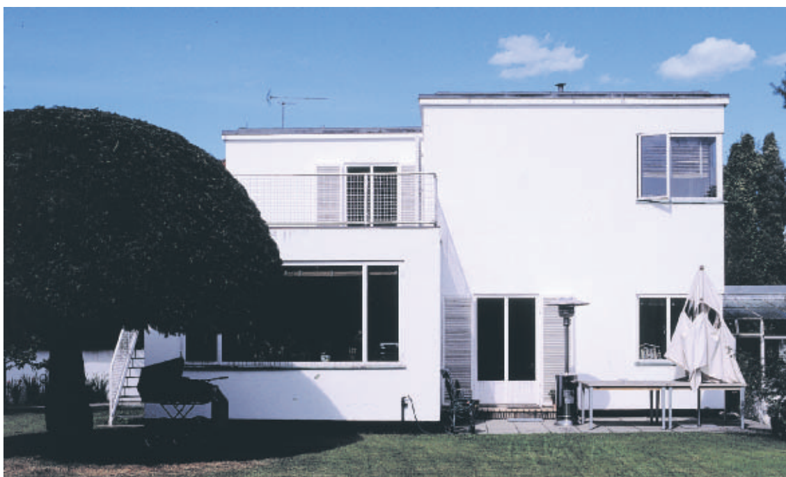
Det første hus Arne Jacobsen tegnede til selv er beliggende på Godfreds Rodesvej 2. Huset signalerer modernisme med sine forskudte kasseformede voluminer, men er dog temmelig konventionelt indrettet.
