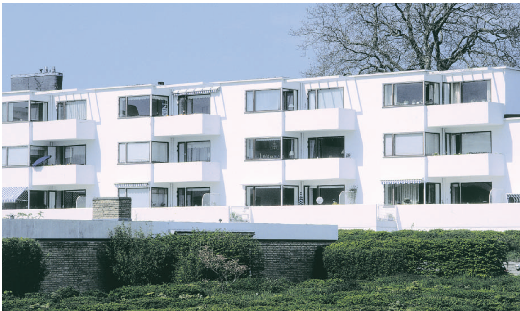
Arne Jacobsens etagehusbebyggelse Bellavista er udformet som et trefløjet anlæg, der åbner sig mod udsigten over Sundet. Bebyggelsen har næsten ikonagtig status, som banebrydende for funktionalismen i Danmark. Huset er opført i mursten, men er pudset ud fra et ønske om at ligne beton.
