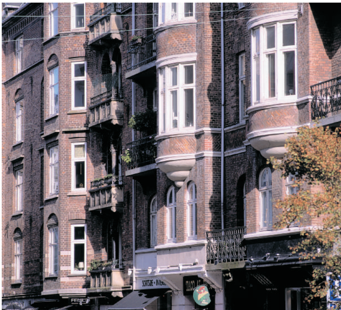
Strandborg på Strandvejen 110-112 er et stort og imponant byggeri, som er opført i 1904 af røde tegl med lyse sandstenspartier i en nationalromantisk stil.
