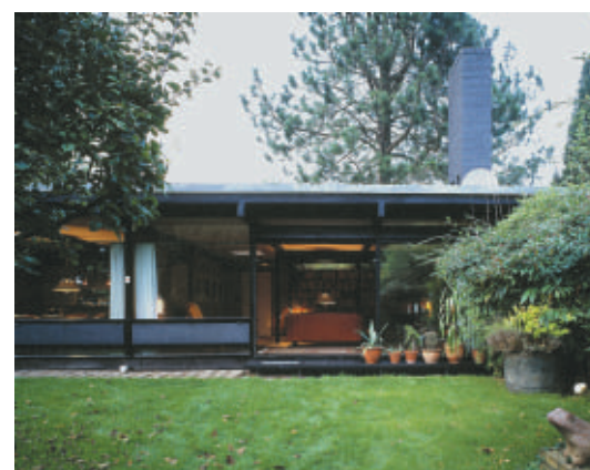
Smutvej 14 er opført som et rent træhus i en konstruktivistisk stil, hvor husets 'bærende og bårne' dele er tydeligt eksponeret i form af sorte stolper og bjælker. Foto: Finn Christoffersen.
