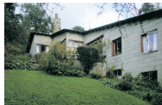
Poul Henningsens eget hus på Brogårdsvej 72 er opført i betonblokke. Husets form følger den stærkt skrånende grund.
