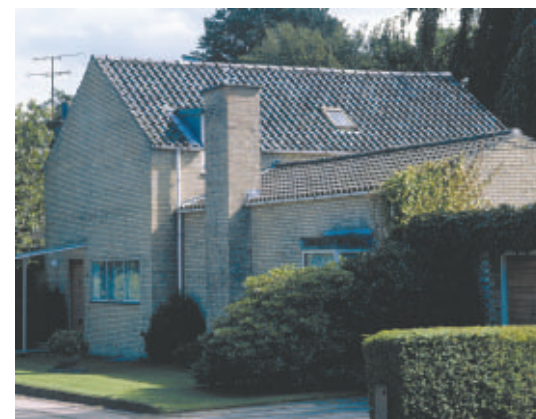
Hegelsvej 17 er sammensat af to enkelt udformede og tværstillede volumener i gule tegl. Udtryksformen er et godt eksempel på den såkaldte 'funktionelle tradition'.
