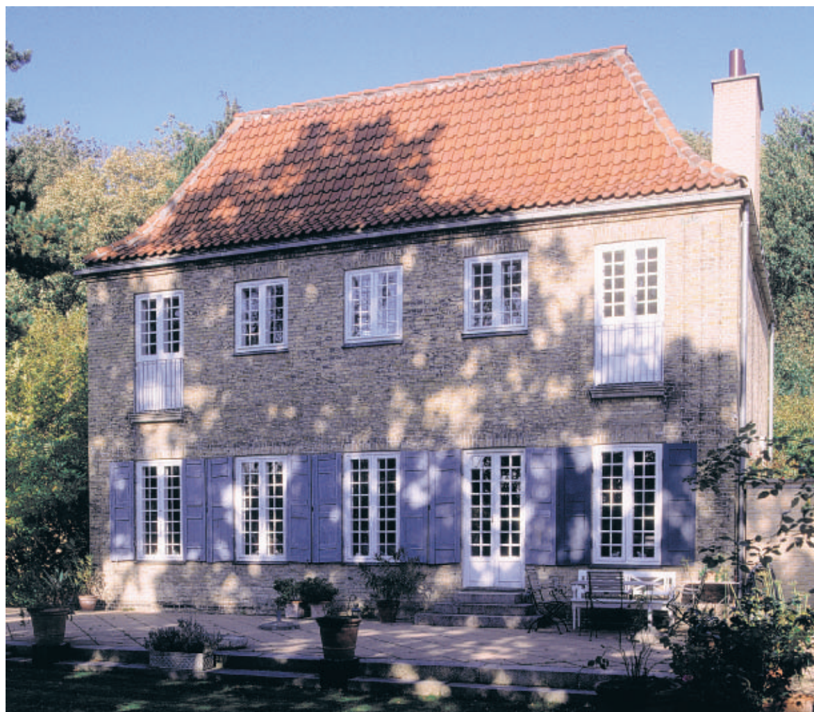
På Dyrehavevej 42 har Jesper Tvede opført et nyklassicistisk hus i to etager med et mansardagtigt tag, der er forsynet med et kraftigt svaj, opskalkning, ved tagfoden. Huset er opført i blank mur og kan minde lidt om Ivar Bentsens Ørnekulsvvej 14.
