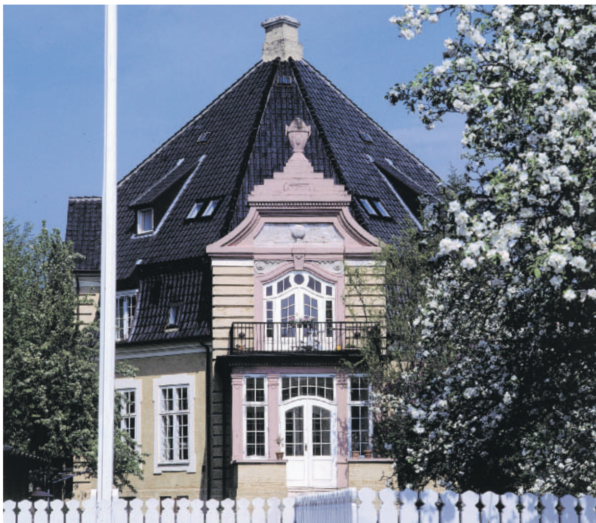
Margrethevej 24 er en imponant, ottekantet villa opført i nybarok og med et stort knækket, pyramideformet tag, der i toppunktet afsluttes af en skorstenspipe.
