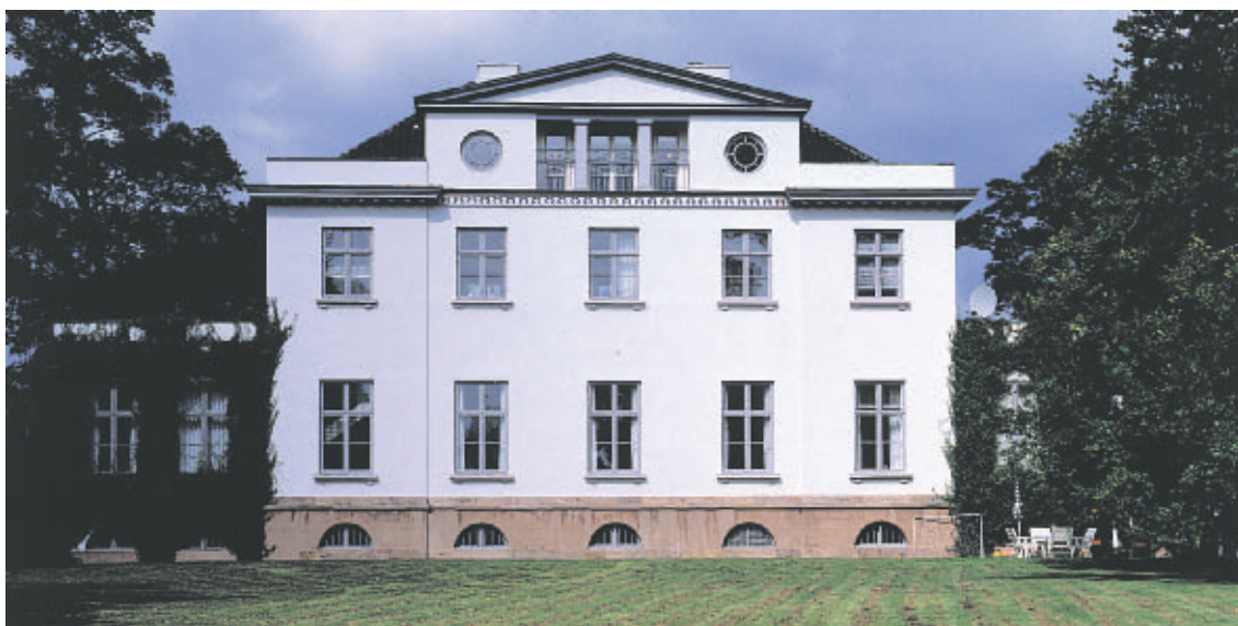
C. F. Hansens Søholm ved Emdrup Sø er et stort, enkelt proportioneret hus med et fremhævet midterparti i hvis øverste etage et tilbagetrukket rum skaber plads for indretning af en loggia.
