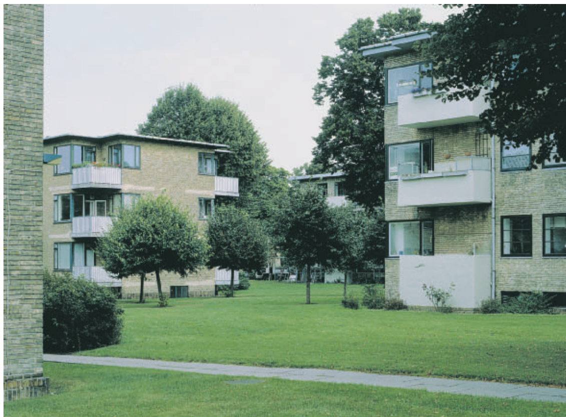
Blidah Park bebyggelsen er opført som fritliggende boligblokke i parken til det tidligere landsted Blidah, hvis navn bebyggelsen har antaget.
