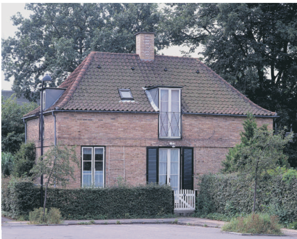
Kay Fiskers to stramt tegnede huse med det helvalmede og opskalkede tag danner en fin afslutning af pladsen ved Lundekrogen.
