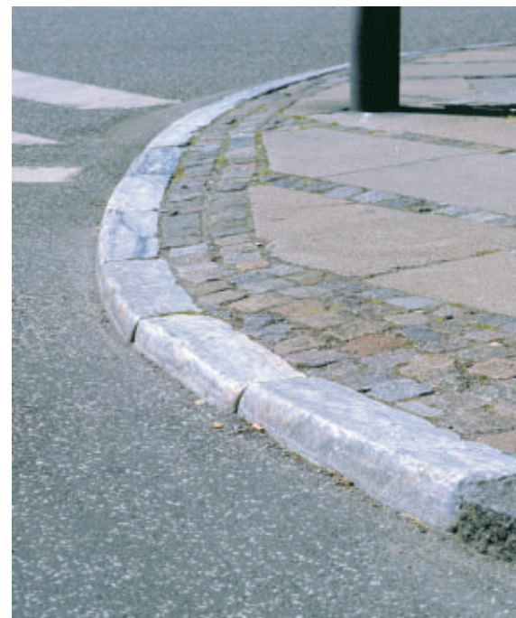
Kantstenene på Charlottenlunds gadehjørner er sat i hvid marmor for at tydeliggøre vejsvinget.
