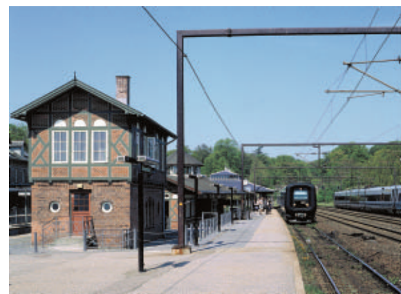
Kystbanens kommandopost på Klampenborg Station er en sammensat bygning med en muret base og det pittoreske, næsten selvstændige hus på første sal. Bygningen er tegnet af overarkitekt H. Wenck.
