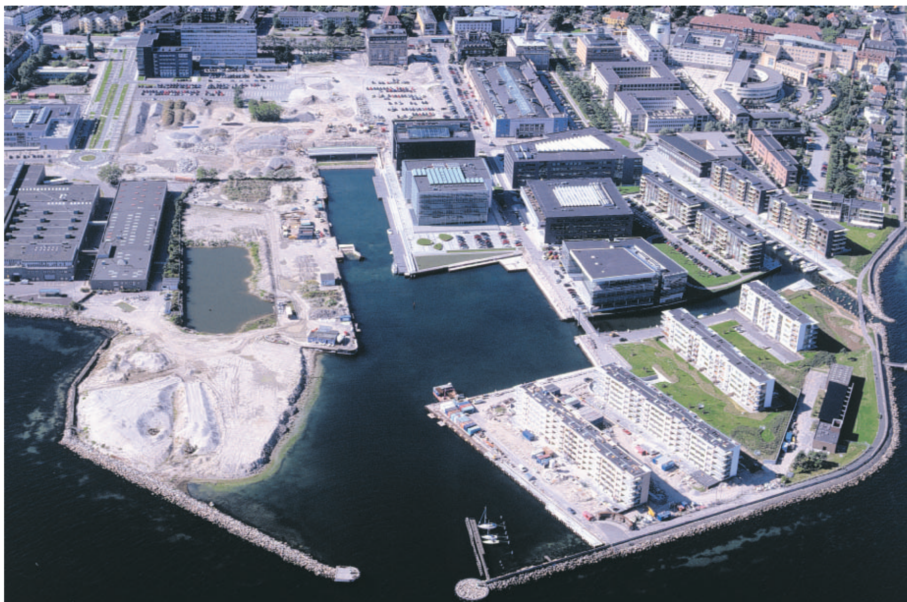
På luftfotoet ses det stort set udbyggede Tuborg Nord til højre og de store byggetomter i Tuborg Syd til venstre. Tuborg Boulevard ses øverst, lidt til højre for midten.
