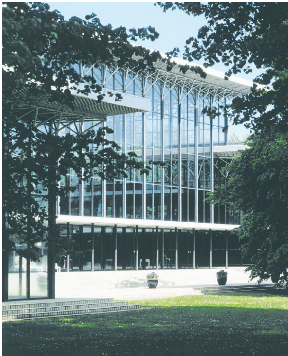
Kildeskovshallens konstruktion med et tagbærende rumgitter og facadens mange tætstillede søjler korresponderer med de omkringstående træers spejlinger i facadens glaspartier.
