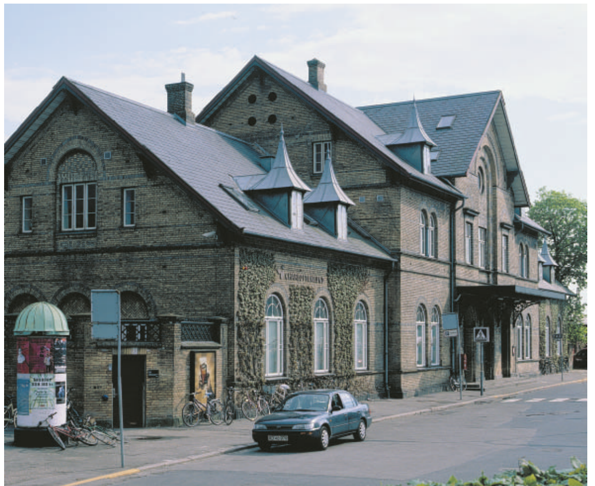
Charlottenlund Station er et stort velproportioneret bygningsværk bestående af en hovedbygning med to sidefløje. Til venstre i billedet ses Aage Paul-Petersens plakatsøjle fra 1923.
