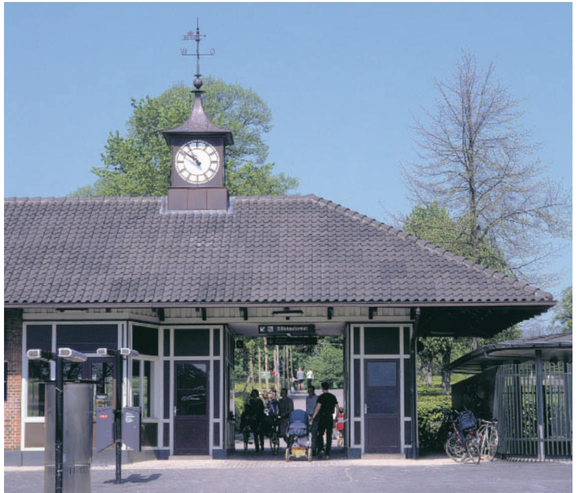
Den tværstillede ekspeditionsbygning på Klampenborg Station samler den syd for liggende, spredte stationsbebyggelse og markerer med sin portgennemgang perronens udstrækning.
