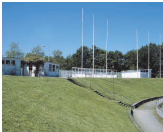
Gentofte Stadion er anlagt i en tidligere lergrav, hvor det omkalfatrede landskab har fået en ny anvendelse.
