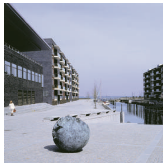
Nye kanalorienterede boliger er opført i den nordlige del af Tuborg Havn.
