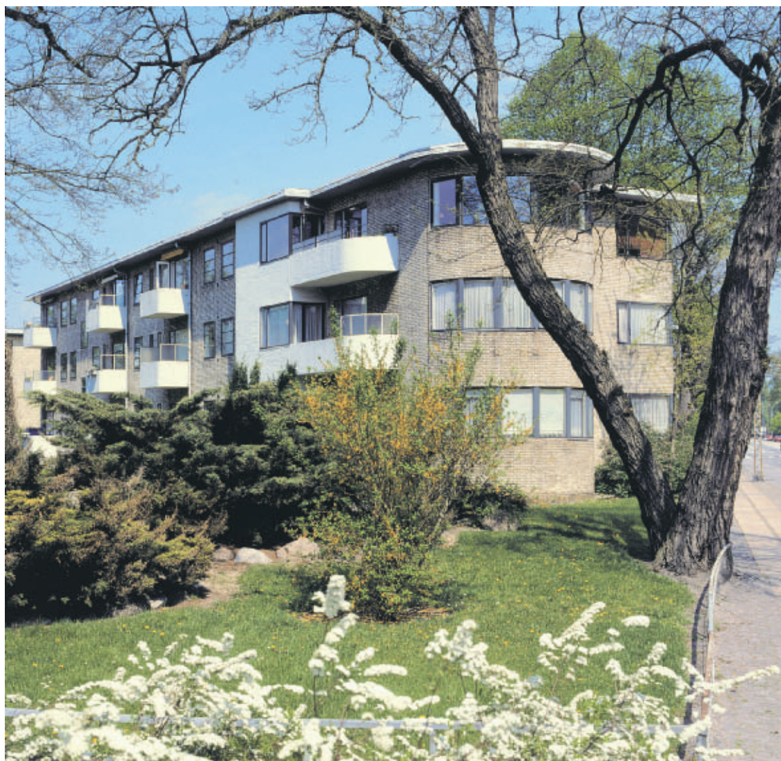
Det funktionalistiske formsprog i Blidah Park har stedvis tydelige maritime referencer i form af store halvrunde karnapper, sammenhængende vinduesbånd og afrundede altanbrystninger.
