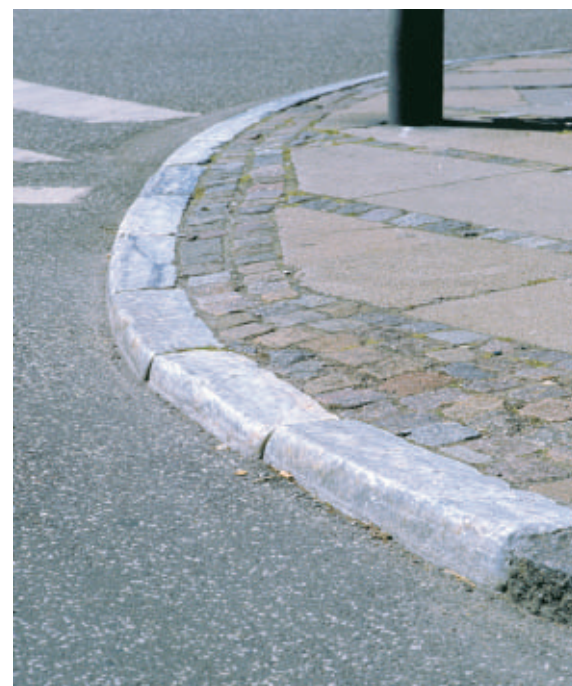
Kantstenene på Charlottenlunds gadehjørner er sat i hvid marmor for at tydeliggøre vejsvinget.
