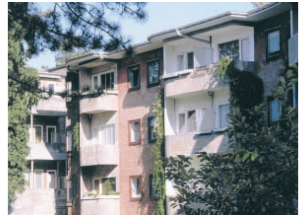
På Ordrupvej 151-179 er i 1930'ernes første halvdel opført en spændende funktionalistisk etagehusbebyggelse med A. Skjøt Petersen som arkitekt.
