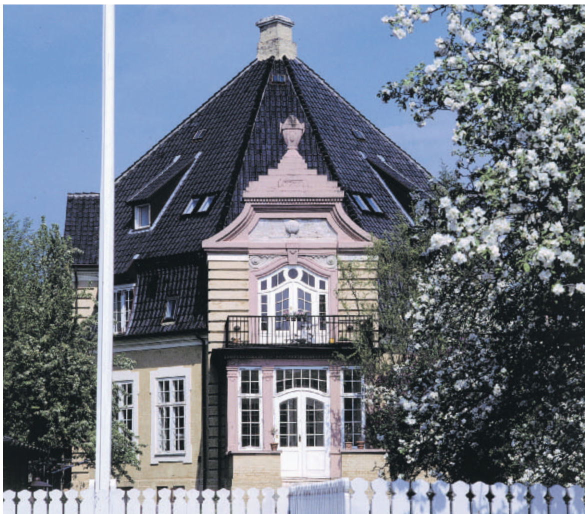
Margrethevej 24 er en imponerende, ottekantede villa opført i nybarok og med et stort knækket, pyramideformet tag, der i toppunktet afsluttes af en skorstenspipe.
